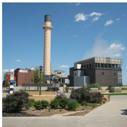
位于美国圣保罗市的可再生热电联产设施，可改善一次能源效率和可再生能源供热。
