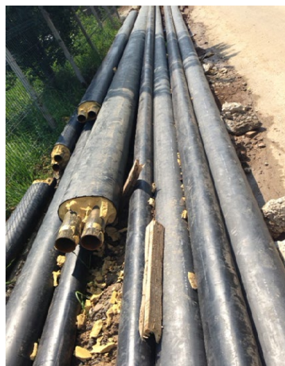
中国新开发的城市（左图）、罗马尼亚博托沙尼隔热的区域供热管道（右图）
