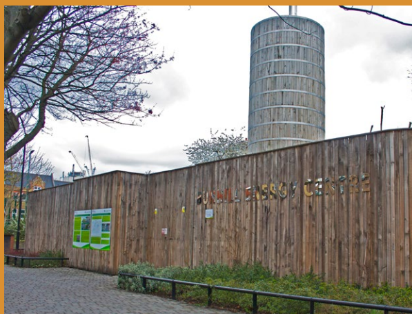
伦敦市伊斯灵顿区的邦希热电厂，该塔是一个大型的储热设施，由此可减少从区域供热系统的备用煤气锅炉获取热力的依赖
