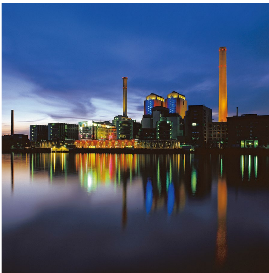
位于德国法兰克福的热电厂
