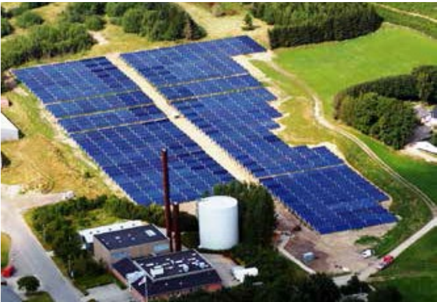
丹麦布雷斯楚普市 (Bræstrup)，配备蓄热器的大型太阳能热电厂并入区域供热网络。
