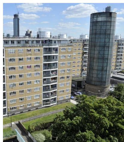
伦敦皮姆利科 (Pimlico) 区域供热公司用来存储该网络过剩热能的玻璃装置
