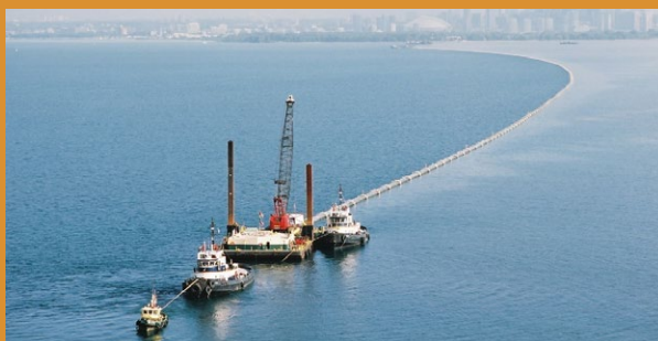
多伦多深水冷却系统正从安大略湖获取冷却水（参见 3.5 节内容）
