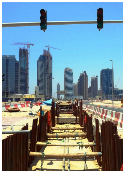
图为阿联酋迪拜正在铺设城市供冷管道
