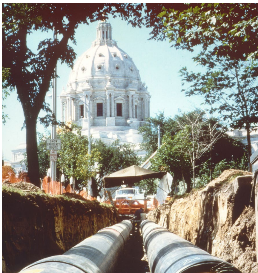
1982年,圣保罗,铺设区域供热管网图。这个供热网络为该市80%的建筑供热,包括图中的明尼苏达州议会大楼。
