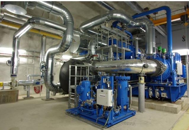
芬兰赫尔辛基市 KatriVala 热泵从城市废水中获取热能
