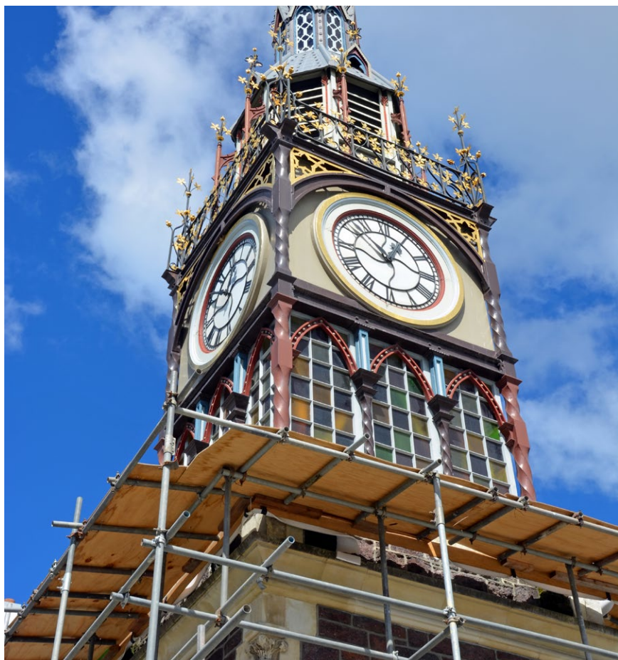
2011年地震后正在进行修复的新西兰基督堂市地标建筑胜利纪念钟塔
